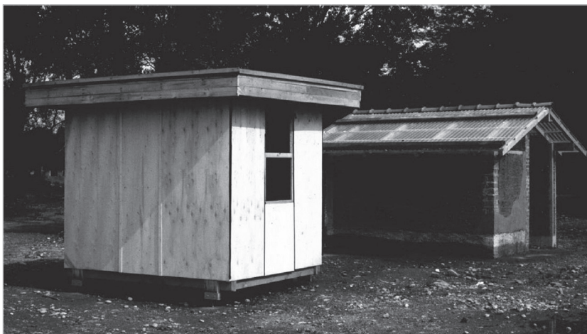
Figura 2 - Piccolo modulo edilizio in legno realizzato con struttura Segal dagli studenti del Corso – Laboratorio Tecnologie Facilitate diretto dai proff. G. Scudo, C. Macchia e arch. G. Cusatelli (anno accademico 1998-1999)
