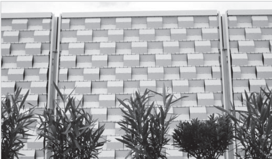
Figura 10.3 - Dettaglio del rivestimento
